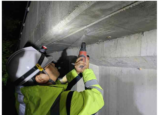
탄산화깊이 측정 현황
